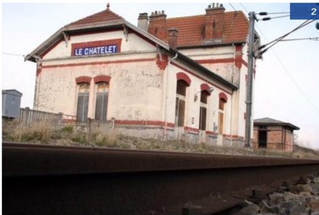
Le passage sous-terrain déjà existant en contrebas de la gare du Châtelet permettrait de limiter la facture d'une réouverture.
